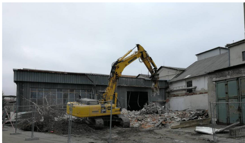
V areálu Cukrovaru již začala demolice prvních objektů.
