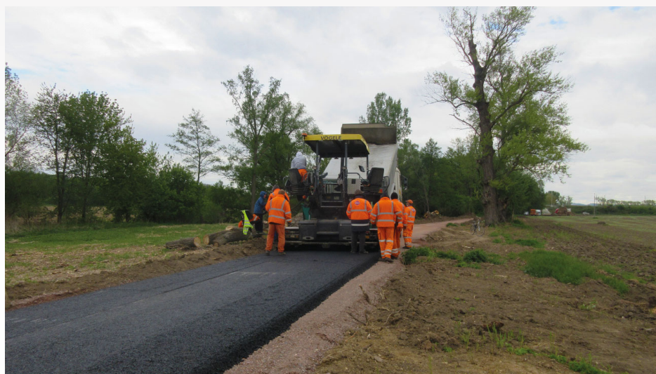
Pokládka asfaltu na budovaném úseku Ponětovice – Kobylnice
