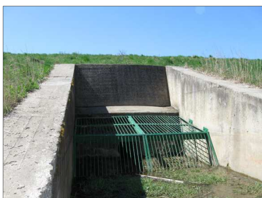
Nátok do výpusti poldru (pod hráz), pohled po toku.
