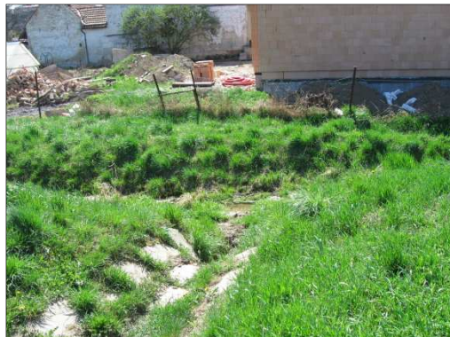
PB zaústění rigolu km 0,293, po toku rigolu
