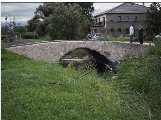
Silniční most km 0,406 pohled proti toku
