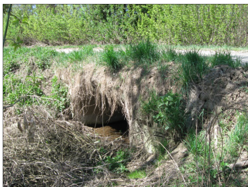
Silniční most (Beneš) km 1,453 - proti toku
