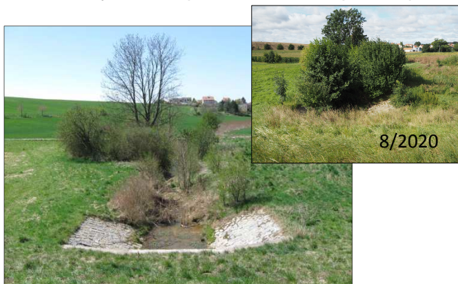
Pohled z hráze po toku.
