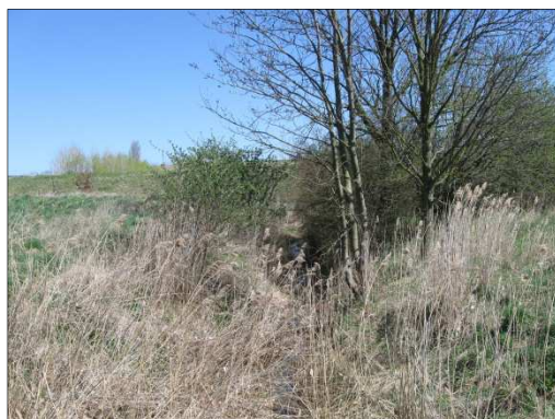
Pohled z propustku proti toku.
