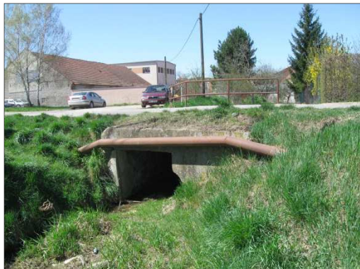
Most silniční km 0,278, po toku a přechod potrubí
