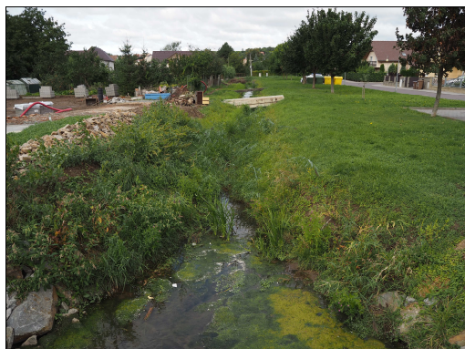
Pohled z mostu po toku
