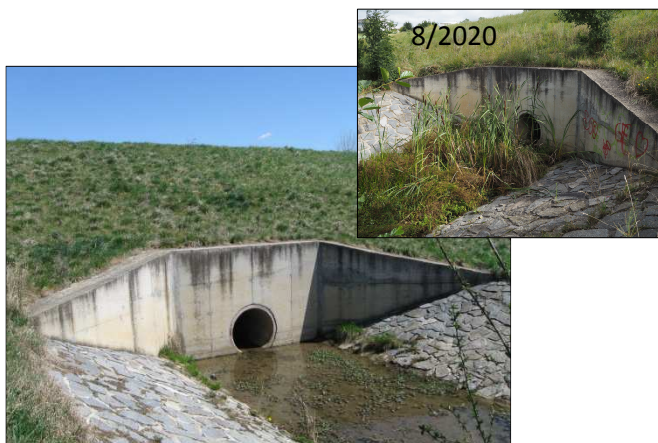
km 0,833 vyústění z poldru DN1000 - pohled proti toku
