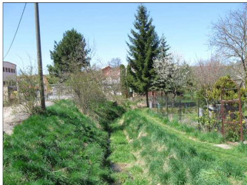
Pohled ze silničního mostu po toku
