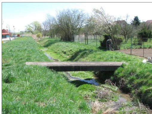
Betonová lávka km 0,351- pohled proti toku
