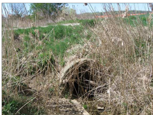
km 0,773 propustek DN 1000 - pohled po toku
