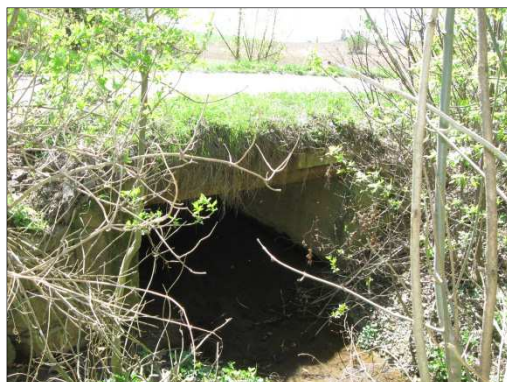
Silniční most km 1,453 – pohled po toku
