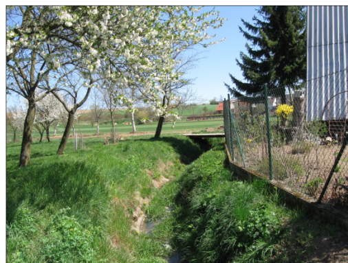
Pohled z lávky km 0,047 proti toku
