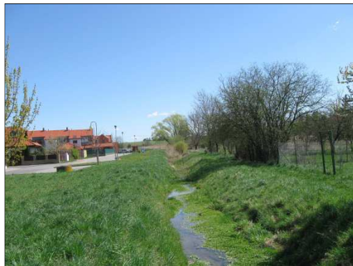
Pohled z lávky km 0,351 proti toku.
