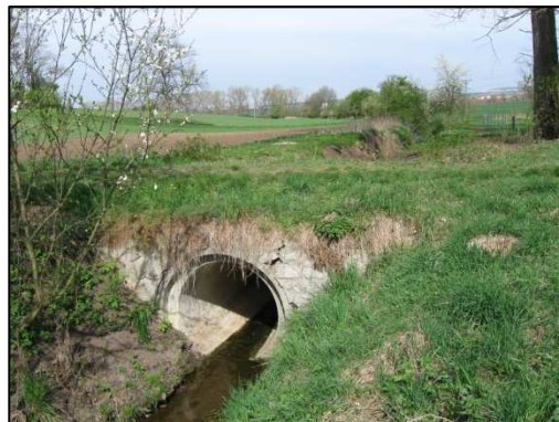
Pohled na propustek km 1,927 po toku.
