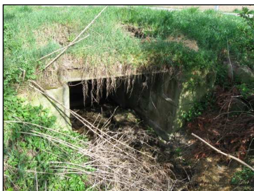
Pohled na most km 0,317 po toku.
