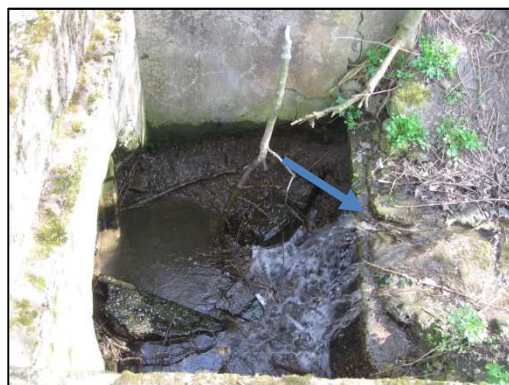
Stupeň nad vtokem do propustku.
