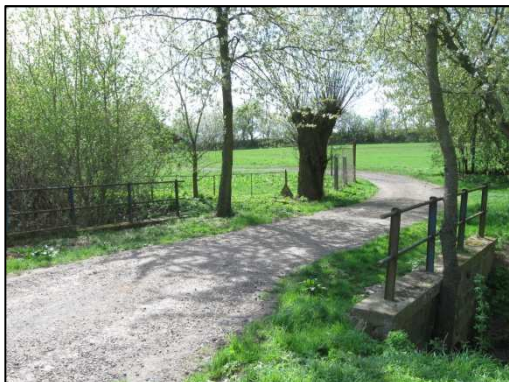
Pohled na propustek z PB.
