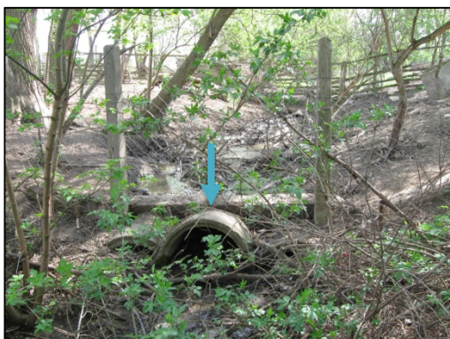
Charakter koryta v neměřeném úseku. Propustky, pohled proti toku
