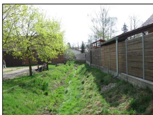
Pohled z mostu km 2,364 proti toku.
