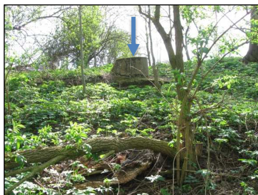
Šachta na hrázi (spadistě).
