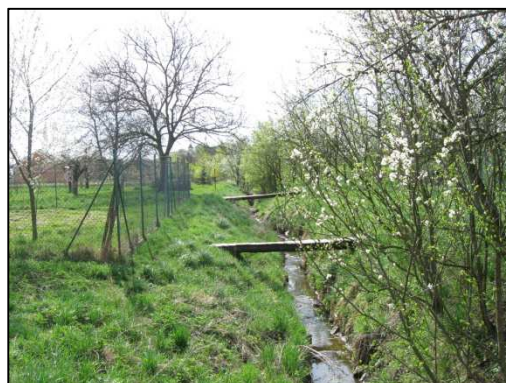
Pohled z propustku proti toku.
