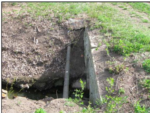
Přechod vedení km 1,927 - pohled z LB.
