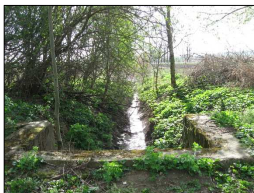
Pohled z propustku proti toku.
