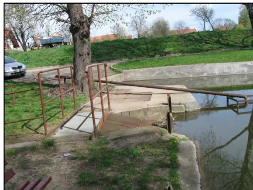
Požerák Dolního rybníka, nátok do zatrubnění DN 1400
