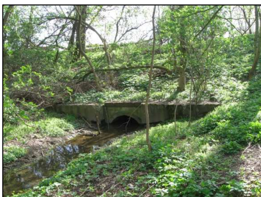
Propustek DN 1200 km 0,149 - pohled proti toku.
