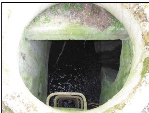
Pohled do zatrubnění - detail šachty
