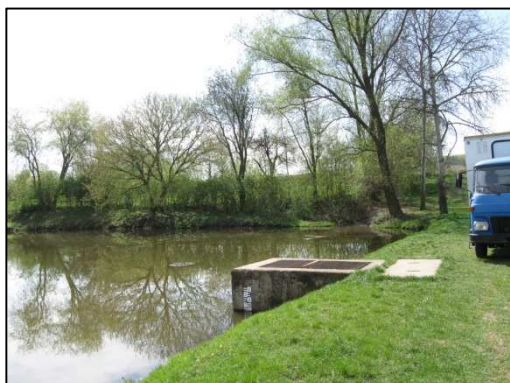
Hráz a požerák Horního rybníka, pohled z PB
