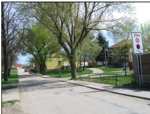
PB inundace z mostu.
