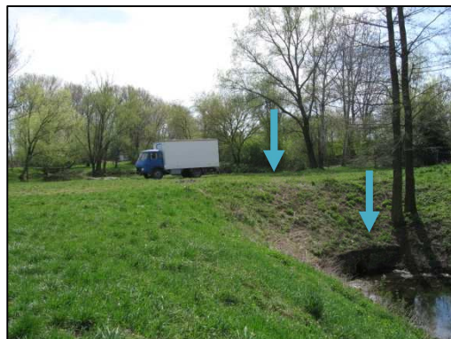
Hráz Horního rybníka, nárust dolního rybníka DN 800
