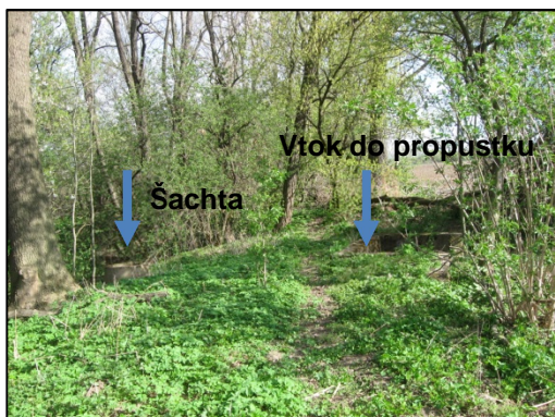
Pohled na propustek z LB.
