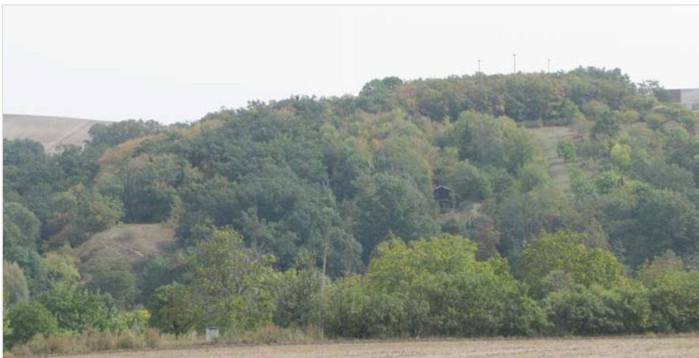
Pohled od západu, vlevo dole světlna nad silnicí, vpravo nahoře areál cihelny
