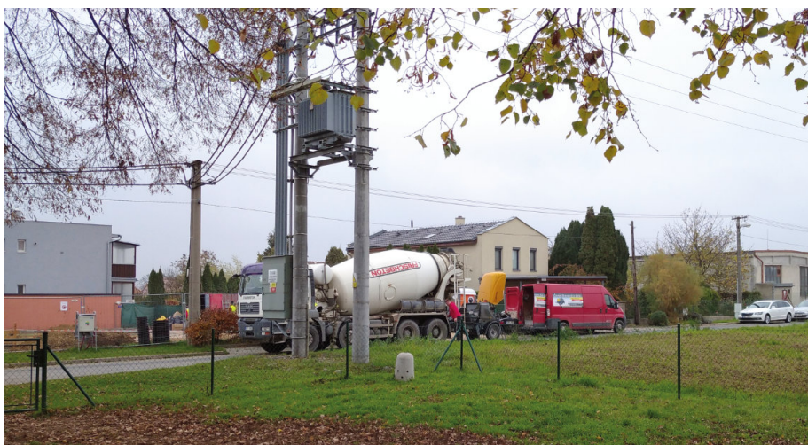
Výstavba mateřské školy na ulici Husova. Foto: Hana Strnadová
