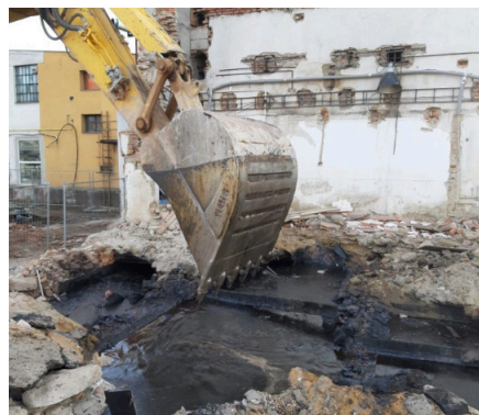
Odkrytí stropu dehtových jámek podél stěny D2 (13. února 2020).
