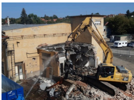
Demolice objektu C (říjen 2020), skrápění pro snížení prašnosti.
