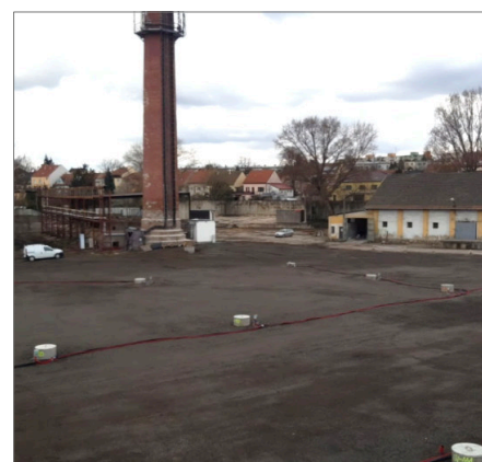
Sanační vrty v ploše demolovaných staveb a odtěžených zemin.
