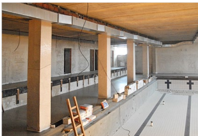
Probíhající rekonstrukce pavilonu B základní školy, foto M. Č.
