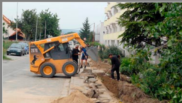
Rekonstrukce plynovodu na Švehlově ulici. Foto: Ondřej Nosek
