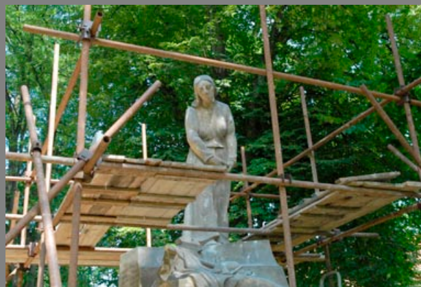
Rekonstrukce pomníku padlých za první světové války. Foto: Ondřej Nosek
