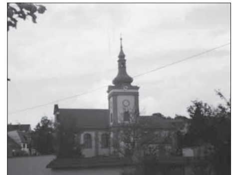
Pohled po demolici Jarolímova statku
