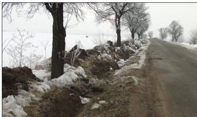
Protipovodňová opatření na Ponětovské ulici 15. února 2006
