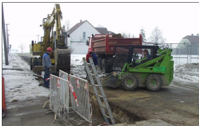
Pokračování stavby oddílné kanalizace 15. února 2006
