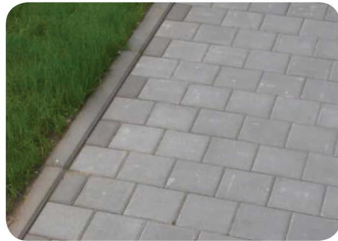
betonová dlažba maloformát dlážděné chodníky, pod lavičkami
