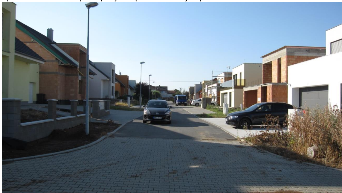
Zástavba kolem ulice Švédské kříže
