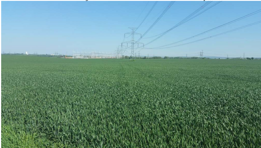
Foto 13: Pohled na stávající trasu VVN v blízkosti navržených koridorů VVN.
