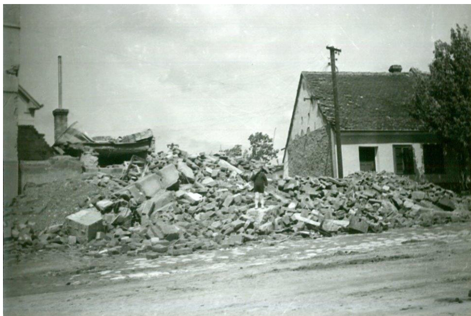
Zřícený dům stavitele Jeteliny na Svatojanském náměstí.
