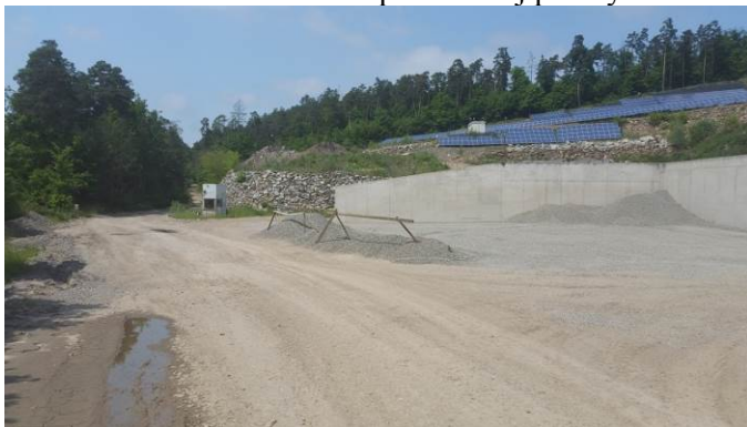
Foto 29: Pohled na severozápadní okraj plochy P21 a trasu koridoru KD2.
