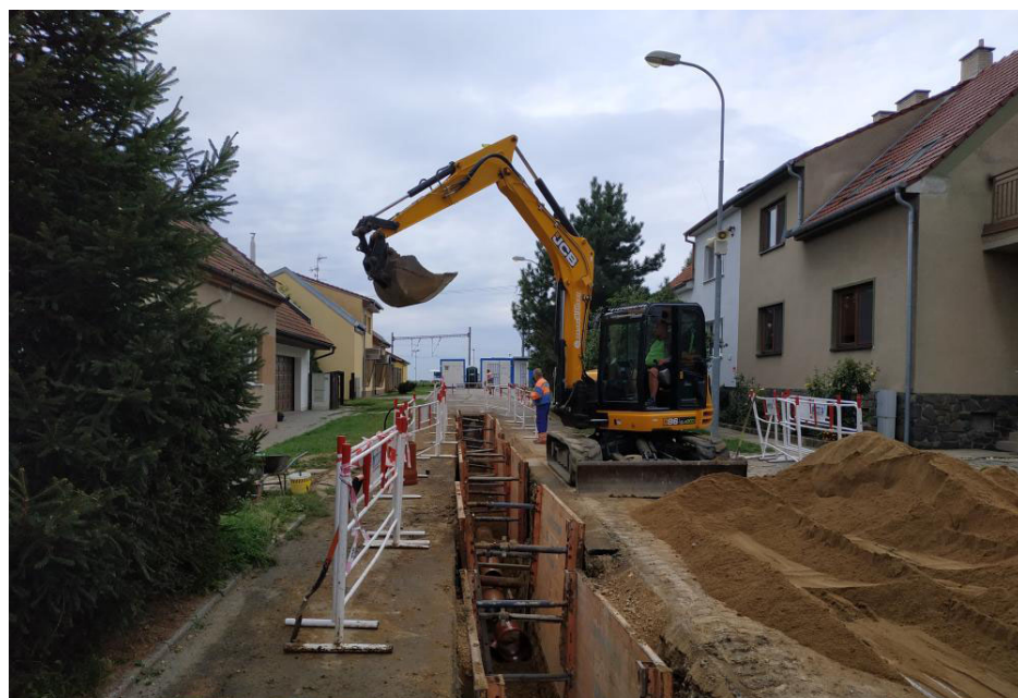
Průběh rekonstrukce ulice Jungmannova
